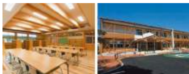
図2 スギ材により建設された綾中学校校舎
