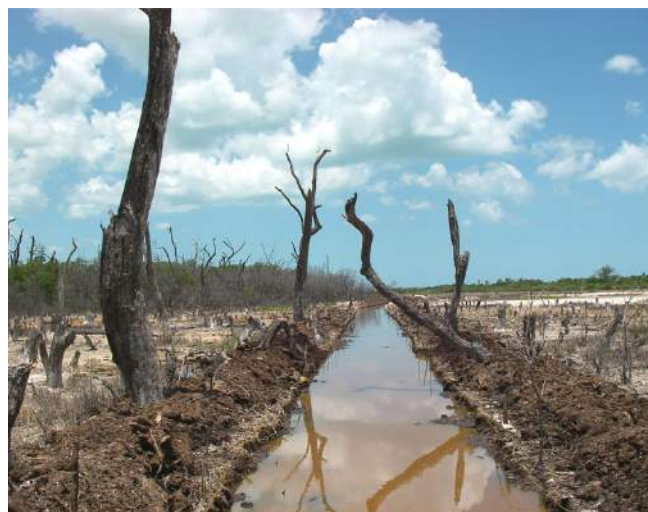
2006年水路建設時 表面に潮が浮いて白くなっていた
